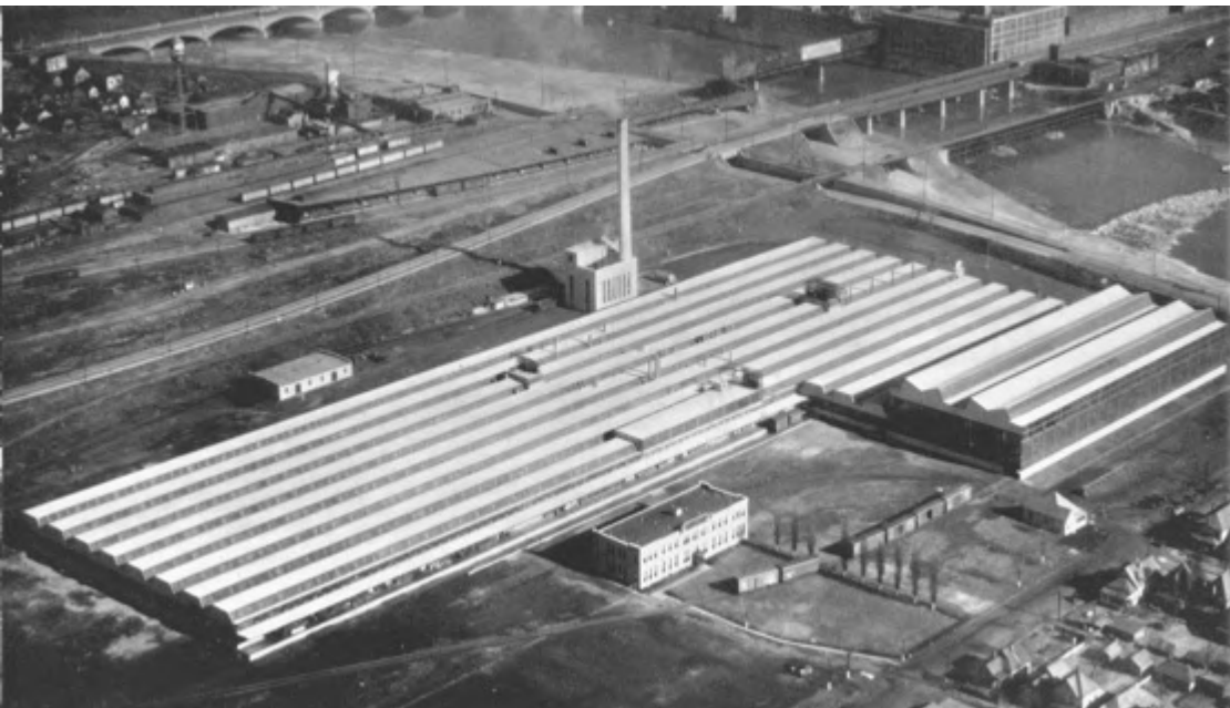
Chevrolet Body Plant, Indiana, 1935 Karosseriewerk unter einem Dach, keine tragenden Innenwände, flexibler Innenausbau
