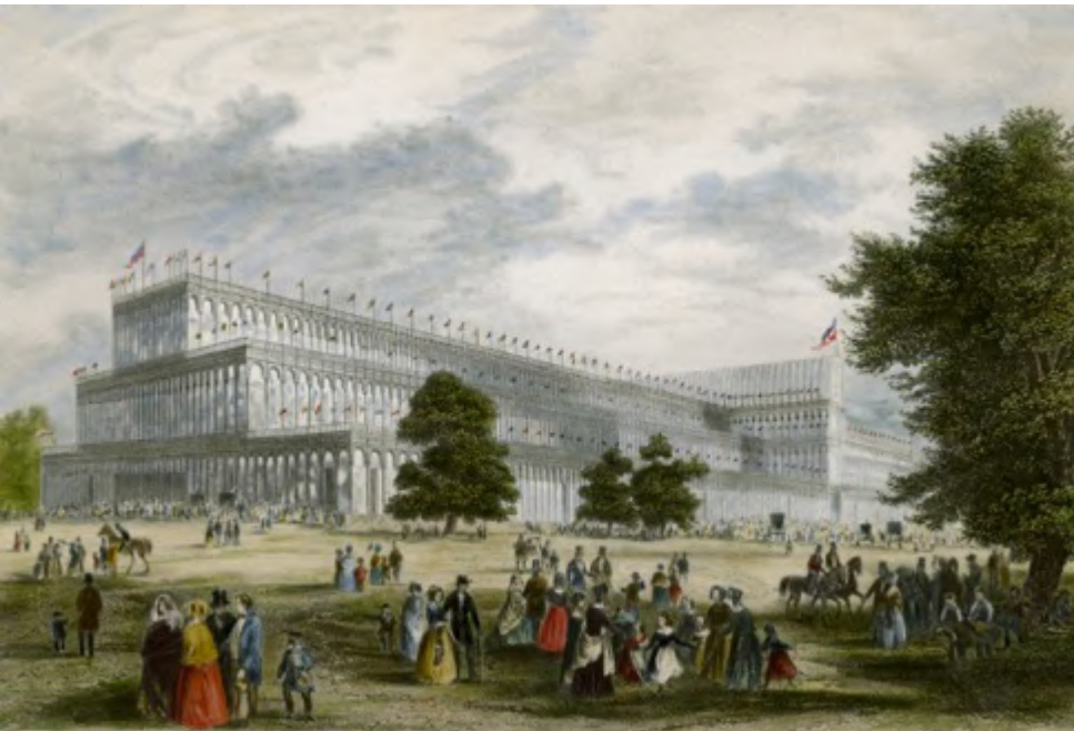
Positionen Mitte des 19.Jh.: Kristallpalast Paxton , London, 1851 Industrielle Elementierung, Eisen, Glas, Spannweite
