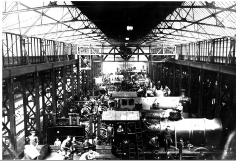
Positionen Ende des 19.Jh.: Kanonenfabrik Essen Krupp um 1870, Borsig in Berlin um 1880 Stahlgashallen, unterspannte Hybridtragwerke, schwere Kranbahnen, Spannweite
