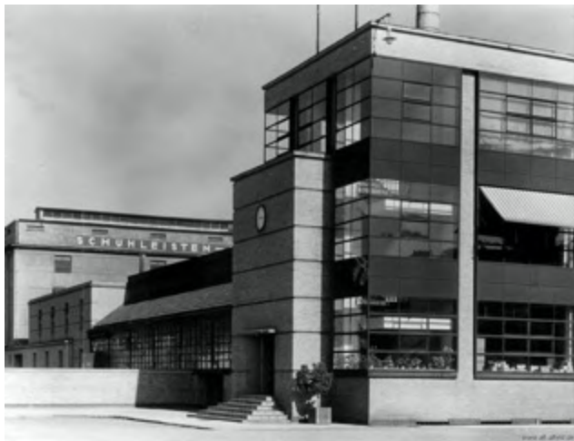
Positionen Anfang des 20.Jh.: Walter Gropius, Erweiterung Schuhleistenfabrik Fagus, Alfeld/ Leine 1911 Klarheit Gebäudekubus, Betonskelett, Glasfassade
