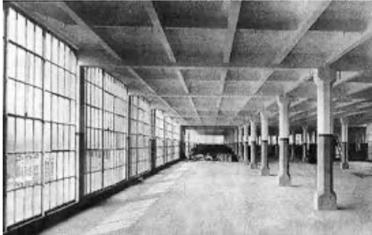
Ernest Ransome, United Shoe Machinery Factory, Beverley, 1902 elementiertes Stahlbetonskelett, Minimierung Außenwände, Tageslichtfabrik
