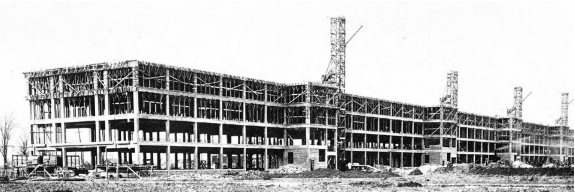
Erste Fabrik Ford, Ford Highland Park, 1909, Detroit, 1909 Stahlverbundkonstruktion, Tageslichtfabrik, Flexible Geschosse durch externe Treppen und Aufzüge
