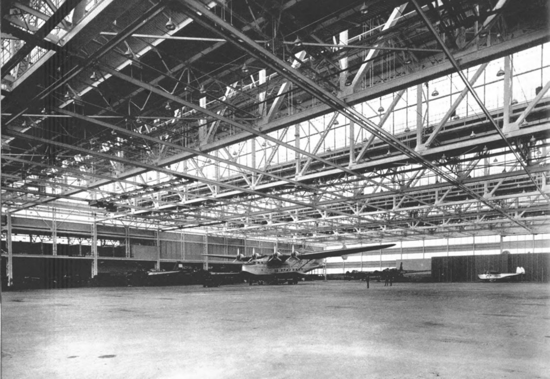
Glenn Martin Bomber Assembly, Baltimore, 1937 300 x 450 Fuss stützenfrei, Stahlbrückenträger
